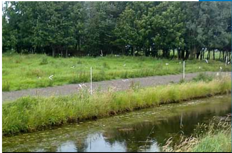
AFRATERING OM HET TALUD TE BESCHERMEN TEGEN VERTRAPPING DOOR KOEIEN OF PAARDEN. SCHAPEN MOGEN WEL OP DIJKEN EN TALUDS GRAZEN.
